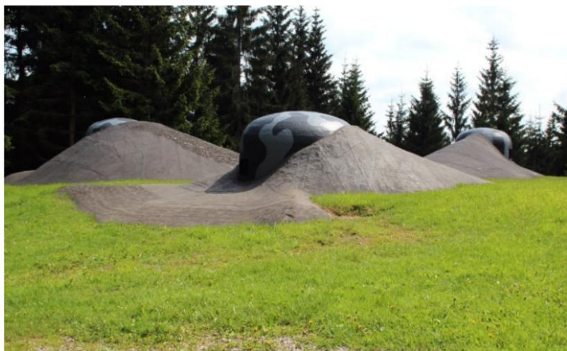
*Nur die einbetonierten Panzerlocken sind oberirdisch sichtbar.*
